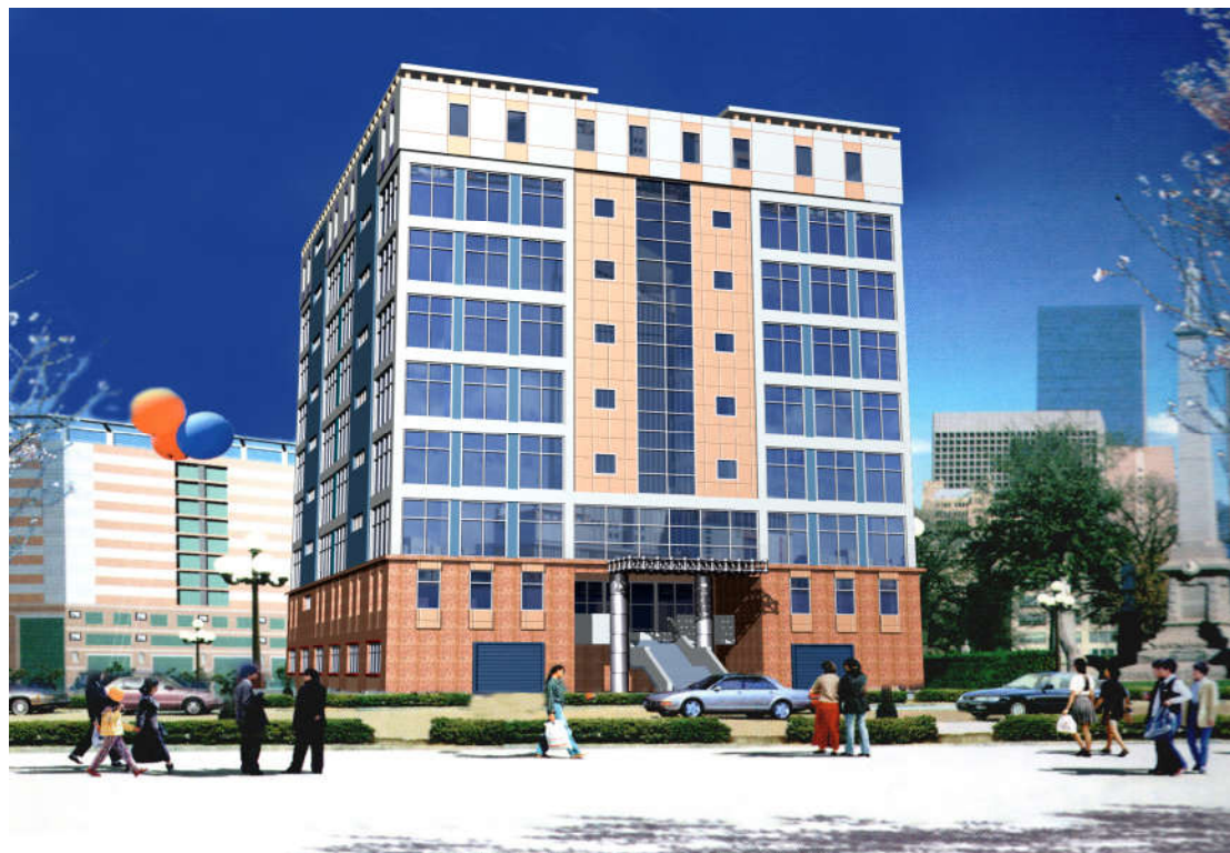
Trụ sở làm việc Công ty Vận tải Khu tiểu thủ công nghiệp - Quận Cầu Giấy - Hà Nội
