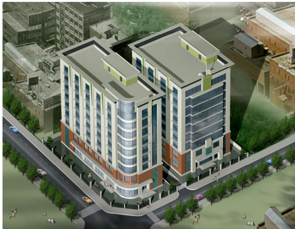
Trụ sở làm việc Nhà máy lọc nước tinh khiết Khu tiểu thủ CN - Quận Cầu Giấy - Hà Nội
