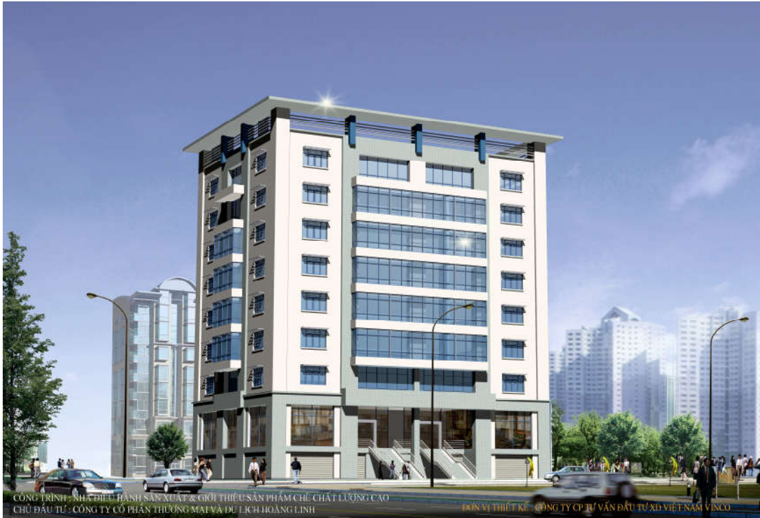
Trụ sở làm việc Công ty Môi trường Khu tiểu thủ công nghiệp - Quận Cầu Giấy - Hà Nội
